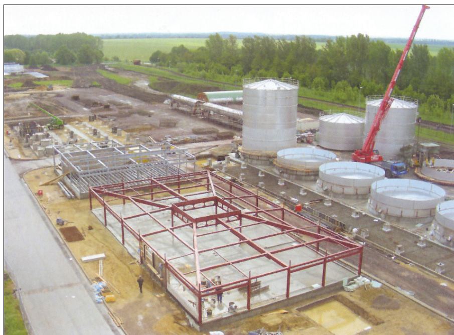
شکل ۲: ساخت قسمت تخمیر ساختمان اداری و فضای ارتباط دو کارخانه قند و الکل، فوندامنت قسمت تقطیر
